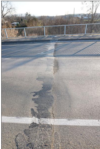
Elastický dilatační závěr u opěry OP4.
