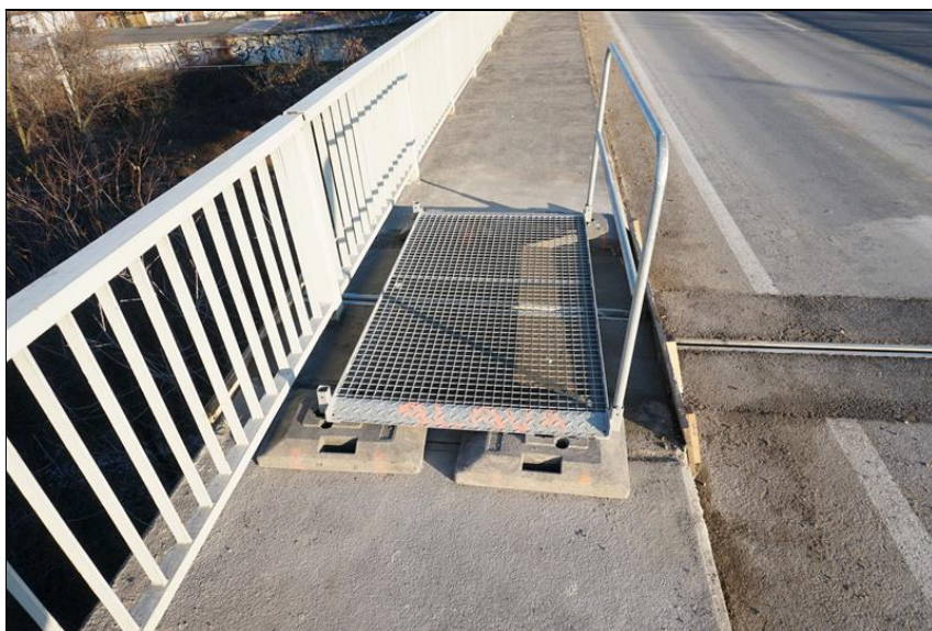
Detail levé strany nově osazeného mostního závěru u opěry OP1.
