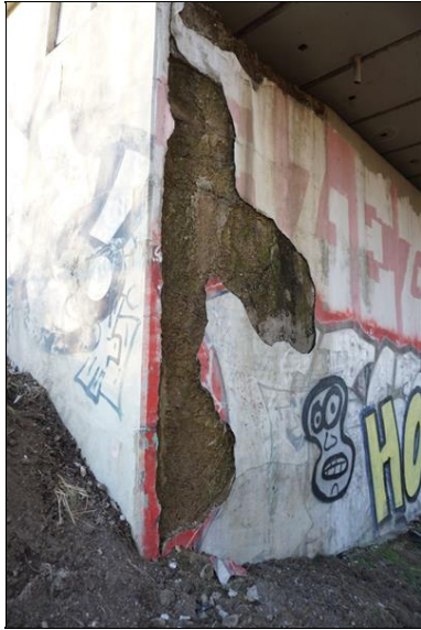
Detail pravé strany opěry OP1. Svislá trhлина od zatékání vody na úložný práh.
